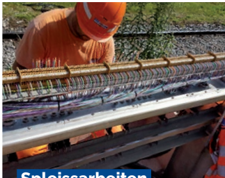
Spleissarbeiten an Kabelverteiltern
