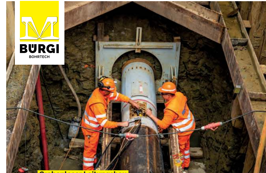
Grabenloser Leitungsbau
