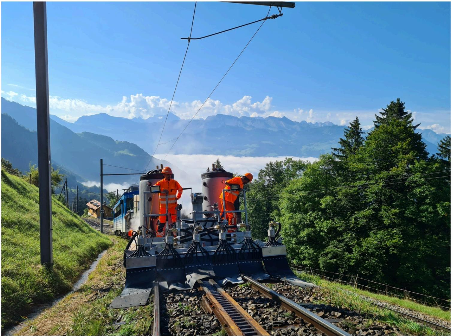
Beim Railex-Verfahren wird ein 130 Grad warmes Wasserdampf-Gemisch durch eine Düse auf die Pflanzen im Gleisbereich gespritzt. Foto: zvg
